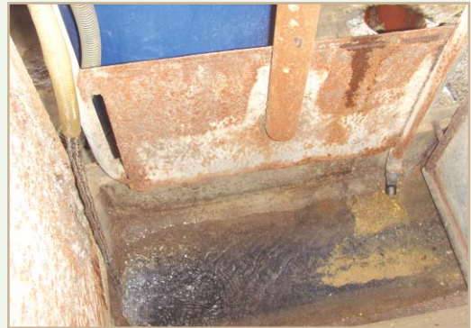
[사진 10] 콘크리트급이기에 급수
